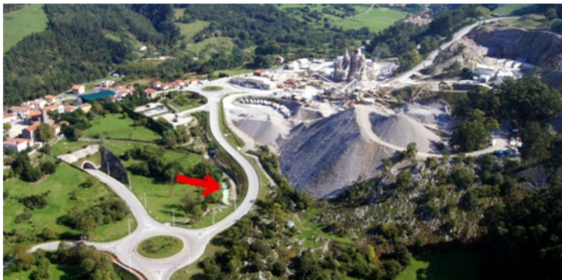
Ubicación de la Balsa de decantación de aguas contaminadas.
